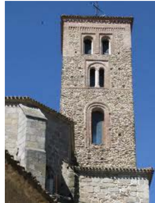
Torre de la Iglesia de Santa María
